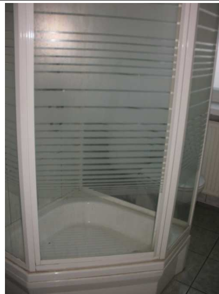
Fot .40 Kabina prysznicowa w łazience (Rys.IA-5 pom.219)
