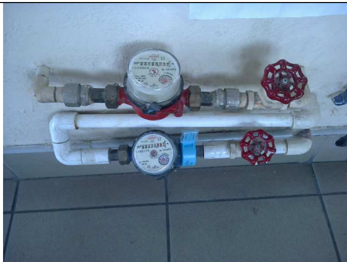
Fot .47 Wodomierz skrzydełkowy (Rys.IA-5 pom.212)
