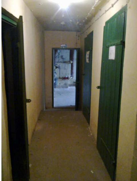
Fot .11 Korytarz piwnicy(Rys.IA-3 korytarz.08)
