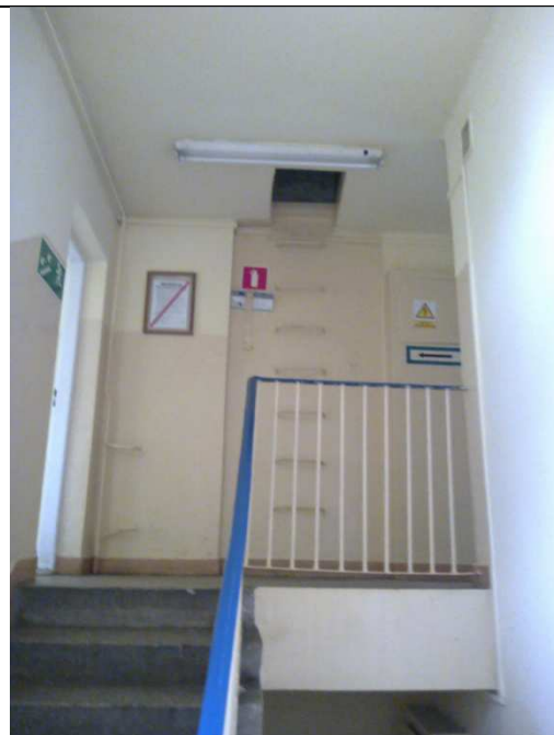
Fot .36 Klatka schodowa na piętro. Widok wejścia na dach (Rys.IA-5 kl.sch.201)
