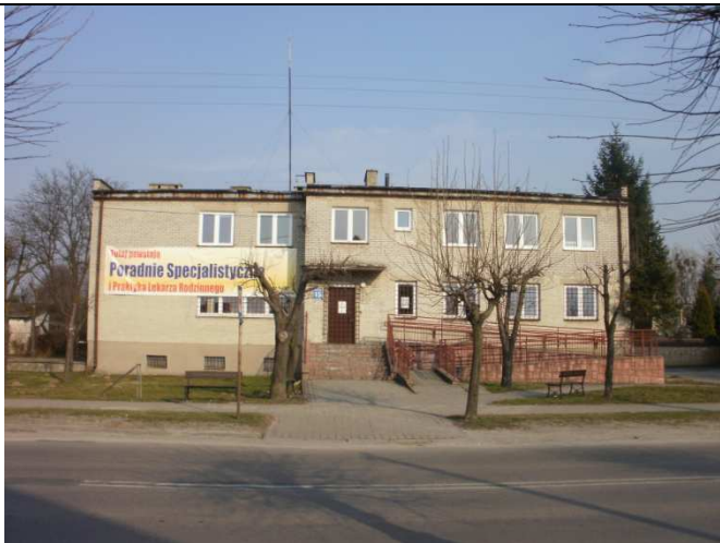
Fot .1 Elewacja zachodnia -frontowa (Rys.IA-1)
