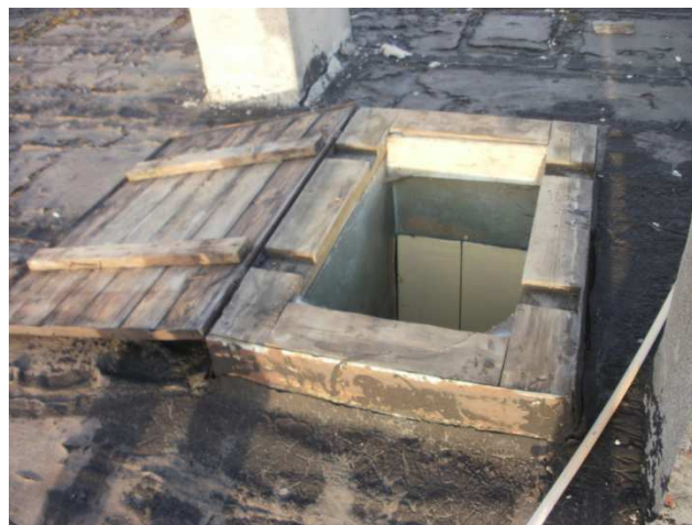
Fot .52 Wyłaz dachowy (Rys.IA-6)
