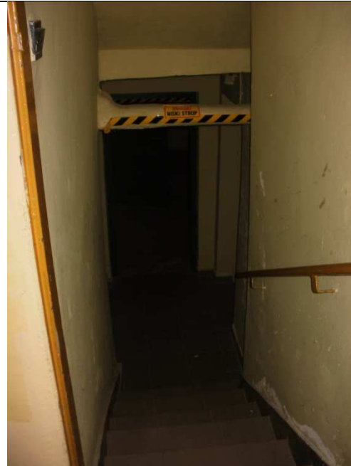
Fot .10 Zejście do piwnicy (Rys.IA-3 pom. 0/1)
