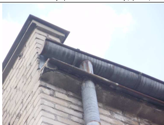
Fot .8 Attyka z rynnowaniem i rurą spustową
