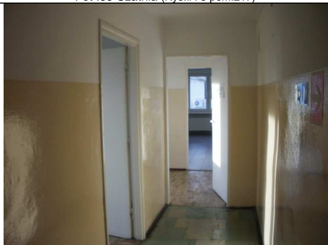
Fot .41 Korytarz części stomatologicznej (Rys.IA-5 korytarz 208)
