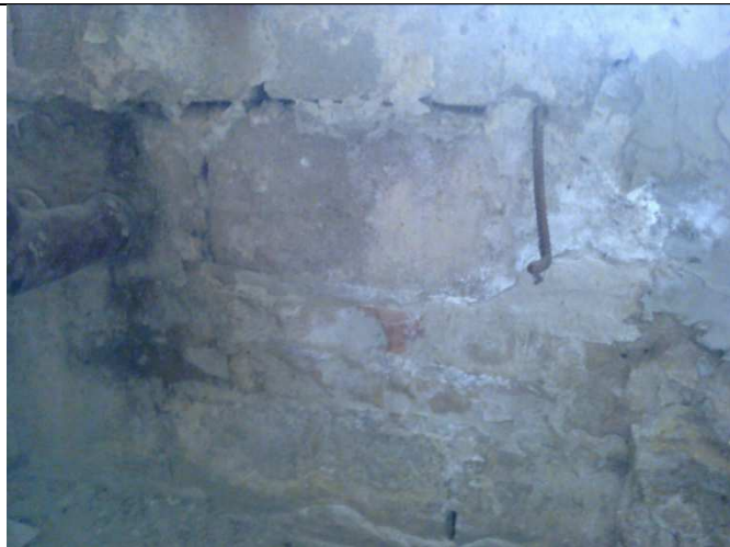
Fot .24 Pustak betonowy ściany zewnętrznej konstrukcyjnej piwnic
