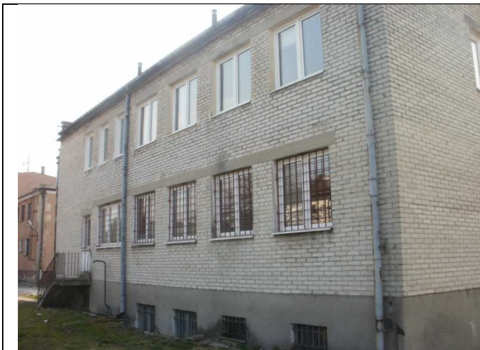
Fot .5 Elewacji wschodnia (Rys.IA-1)
