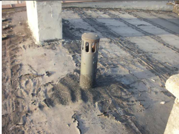
Fot .51 Widok pokrycia dachowego z wywiewką kanalizacyjną (Rys.IA-6)
