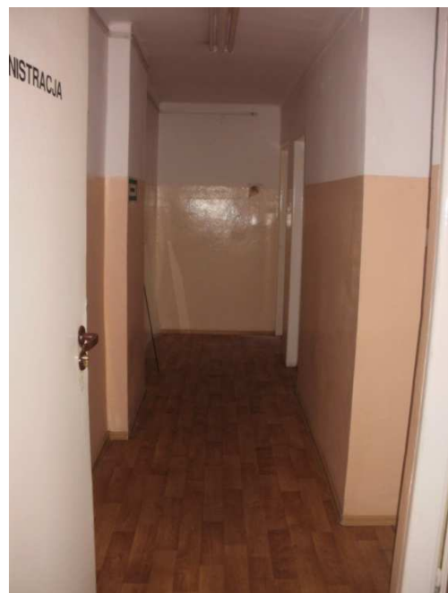
Fot .38 Wejście do części administracyjnej (Rys.IA-5 korytarz 216)
