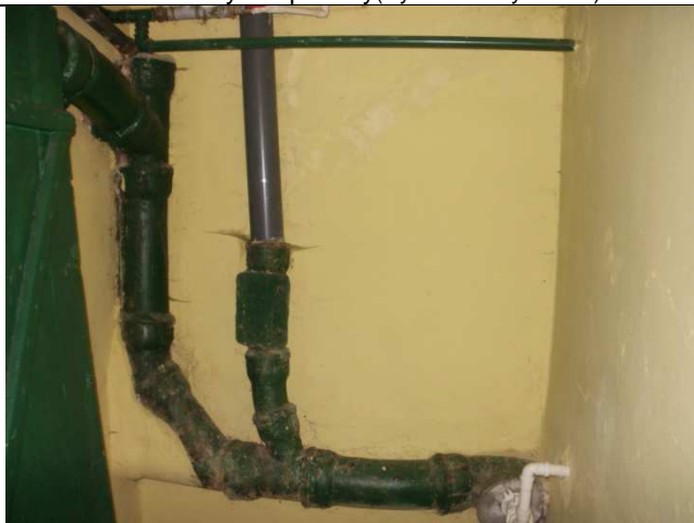
Fot .13 Wyjście instalacji kanalizacyjnej z budynku (Rys.IA-3 korytarz.08)
