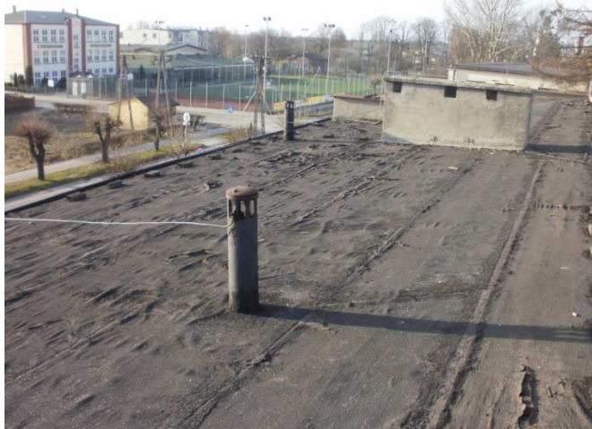
Fot .49 Widok dachu-str. zachodnia (Rys.IA-6)
