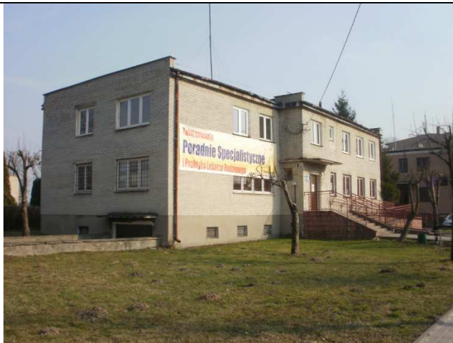
Fot .2 Widok elewacji od strony północno- zachodniej (Rys.IA-1)
