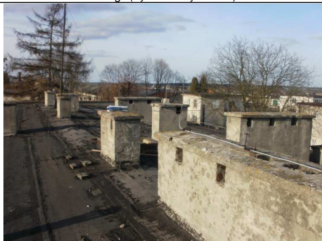
Fot .50 Widok dachu-str. wschodnia (Rys.IA-6)
