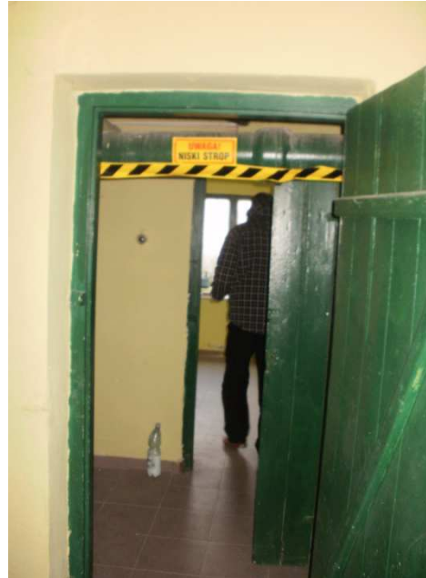
Fot .12 Korytarz piwnicy(Rys.IA-3 wnęka 03)
