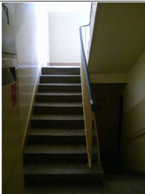
Fot .25 Klatka schodowa (Rys.IA-4 klatka sch.108)
